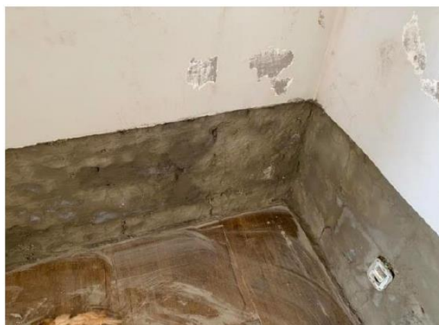
Foto 02 – Exemplo de remoção do revestimento
