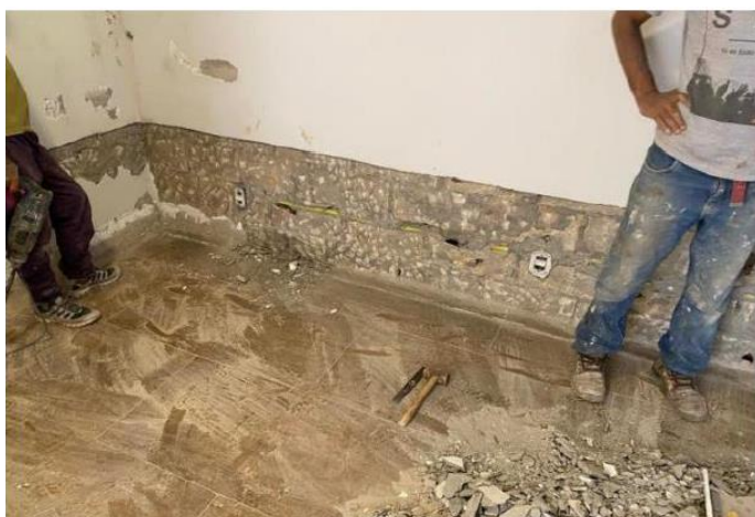
Foto 01 – Exemplo de remoção do revestimento
